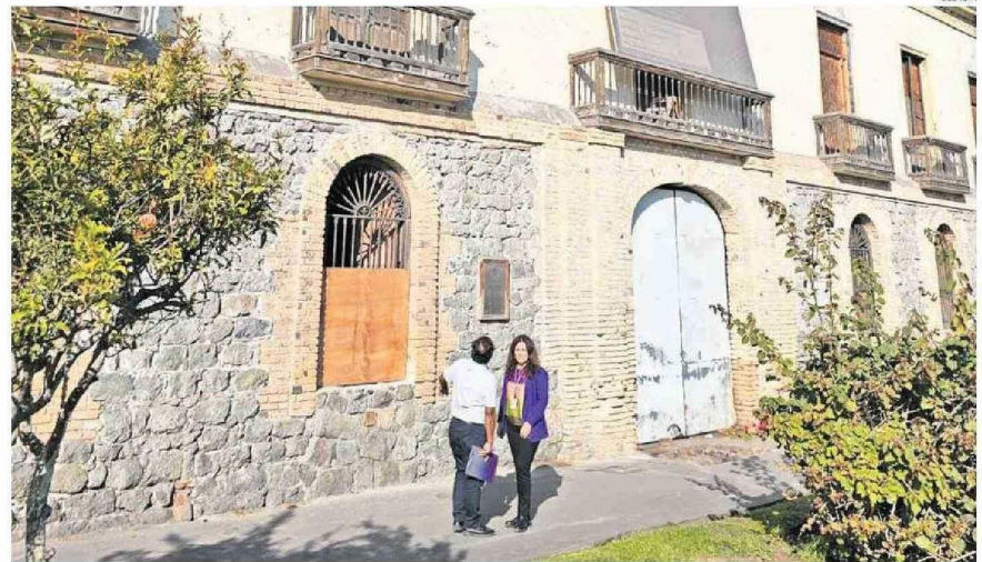
CON ESTA APROBACIÓN SE AVANZARÁ A LA ETAPA DE RESTAURACIÓN DEL EDIFICIO.
