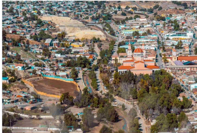
El trabajo requirió más de 2.500 viajes de camión para trasladar el material del relave y confinarlo.
