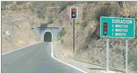
La licitación para construir el Túnel La Grupa II está en proceso y concluirá a fines de noviembre.
