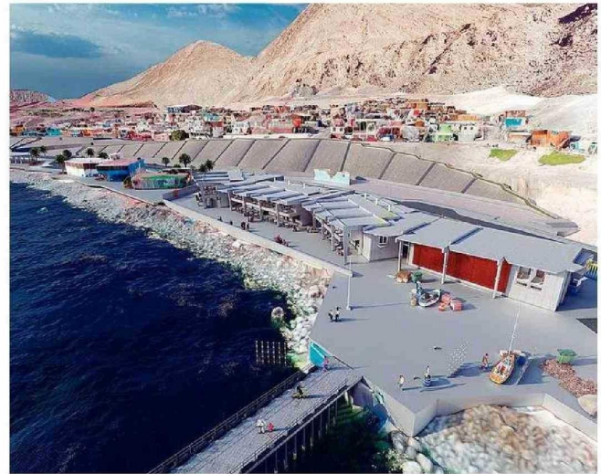
LAS OBRAS SE DESARROLLARÁN EN UN TERRENO DE CUATRO MIL METROS CUADRADOS.
