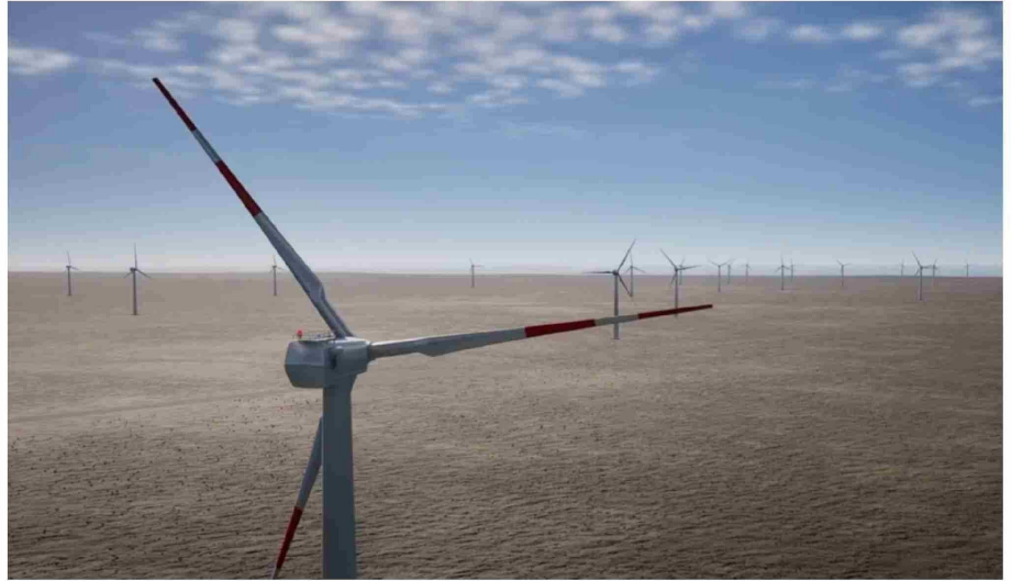
EL PARQUE EÓLICO DE HNH EN SAN GREGORIO GENERARÁ UNA POTENCIA DE 1,4 GW DESTINADOS A ALIMENTAR EL PROCESO DE ELECTROLISIS NECESARIO PARA GENERAR AMONIACO VERDE. EL PROYECTO ESTÁ EN CALIFICACIÓN.
