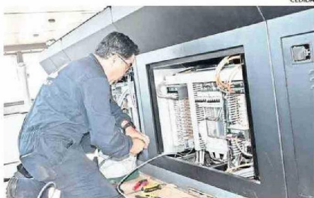
TRABAJADORES DE ASMAR EN LA INSTALACIÓN DE EQUIPOS.
