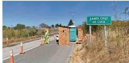
TRABAJOS LLEVAN UN 45% DE AVANCES.
