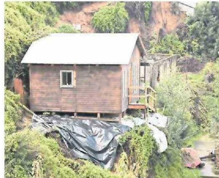
SE ESTÁN REALIZANDO TRABAJOS PARA EVITAR NUEVOS DERRUMBES.
