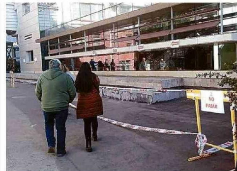
SE INSTALÓ UN CIERRE PERIMETRAL POR CALLE ÁLVAREZ.
