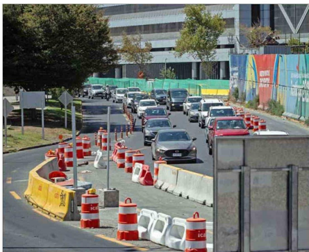
TRABAJOS. — Son varios puntos de la capital en los que se están desarrollando obras viales. En la imagen, el eje Alameda-Providencia.
