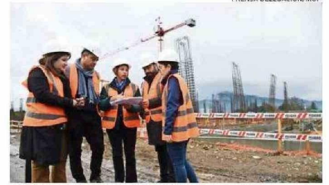
ALCALDE Y AUTORIDADES REGIONALES RECORRIERON OBRAS.
