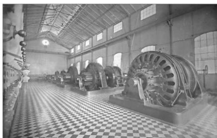
Las turbinas de Victoria 612. Desde este punto en Santiago se generaba la energía eléctrica para la ciudad y la red tranviaria.
