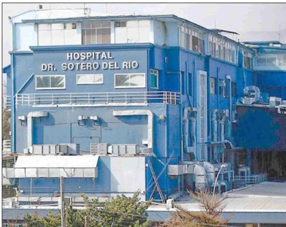
Hospital Sótero del Río en Puente Alto.
