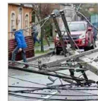
Un tornado voló techos y derribó árboles y postes en Penso.
