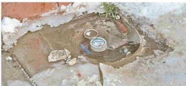
La falta de protección de este medidor en un domicilio de pasaje Kolkkaiké, en la villa Selknam, hizo que el equipo se reventara, escurriendo el agua por el pasaje.
