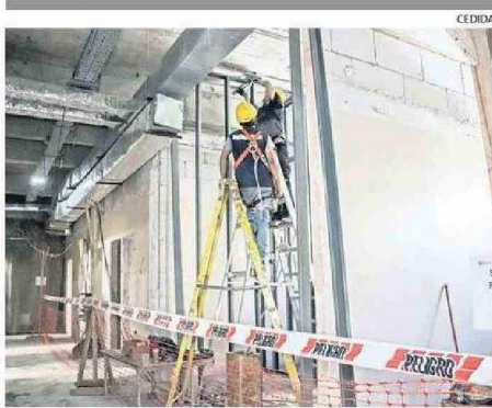
CONSTRUCCIÓN DE PABELLONES EN EL HOSPITAL HIGUERAS.
