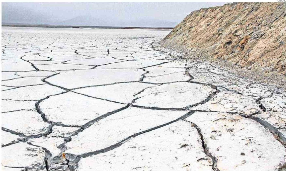
EL TRANQUE DE RELAVES MINERO DE TALABRE, DE LAS OPERACIONES DE CODELCO, ESTÁ EMPLAZADO A 13 KILÓMETROS AL NORORIENTE DE CALAMA.
