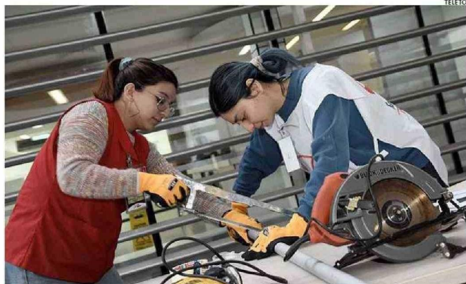
EN LA REGIÓN DE TARAPACÁ SE INTERVENDRÁN 12 VIVIENDAS.
