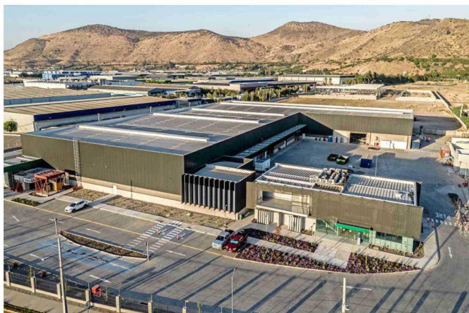
Centro de Clasificación y Pretratamiento para la Valorización de Residuos "GIRI", de Ambipar Environment.
