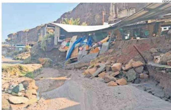
UNA DE LAS CASAS AFECTADAS POR LAS LLUVIAS Y EL DESBORDE DE LOS RÍOS EN EL PUEBLO DE CASPANA.
