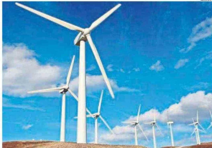
LA DECISIÓN TAMBIÉN SE FUNDAMENTA EN LOS PROBLEMAS QUE LA FIRMA TIENE EN PROYECTOS EN EL SUR DEL PAÍS.
