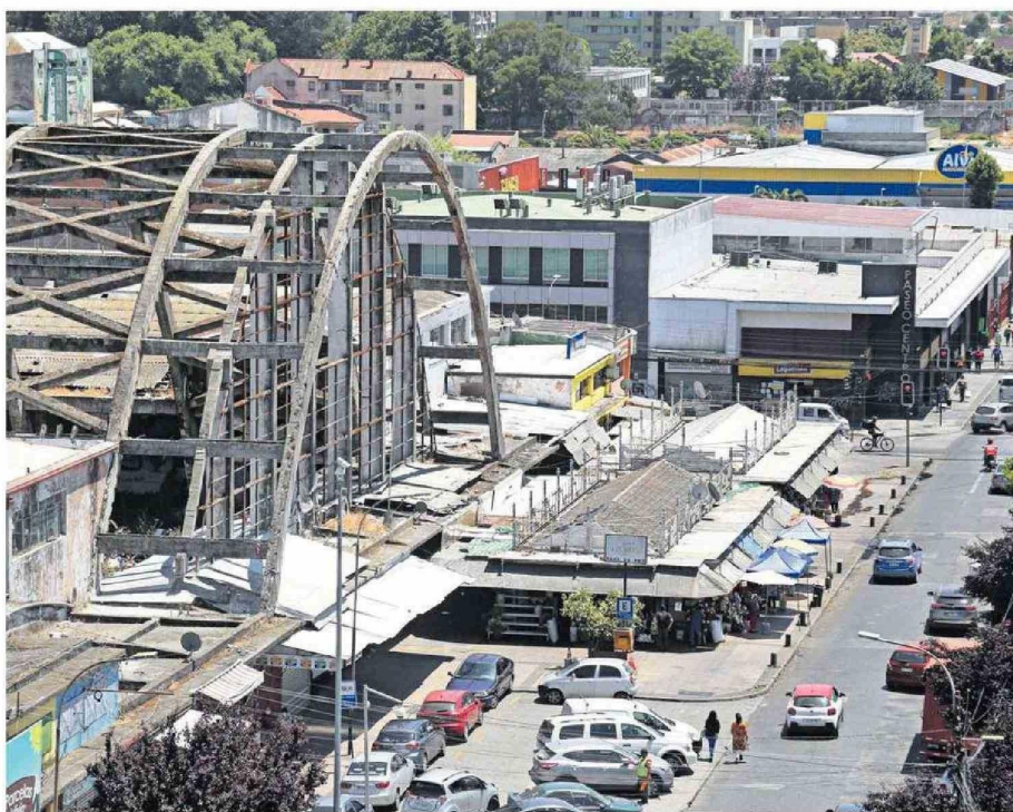
En abril de 2013, un incendio arrasó con el 70% del histórico Mercado de Concepción. A once años, aún no han habido arreglos o mejoras.
