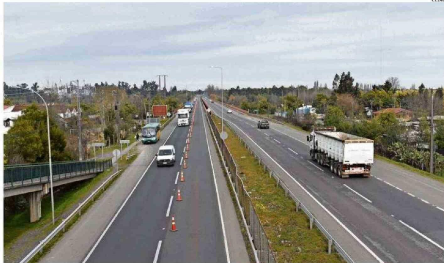
36 LOTES SE EXPROPIARÁN PARA CONTAR CON TERCERA PISTA ENTRE SAN CARLOS Y CHILLÁN VIEJO.
