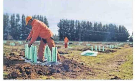
En sector Cullin-Palihue de Cañete inició la restauración.
