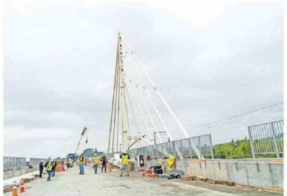
Mástiles permitirán reducir la exposición al viento de los trenes.
