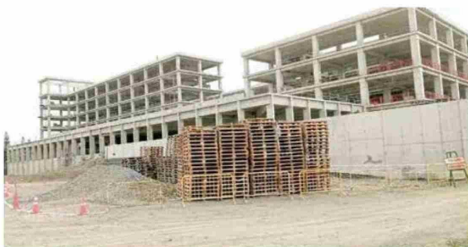
El hospital provincial estaría concluido el 2028, con 329 camas, ocho pabellones quirúrgicos y tres salas de parto integral.
