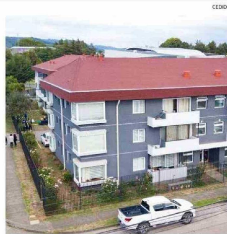
LOS TRABAJOS OTORGAN UNA MEJOR CALIDAD DE VIDA A LOS VECINOS DEL CONDOMINIO.
