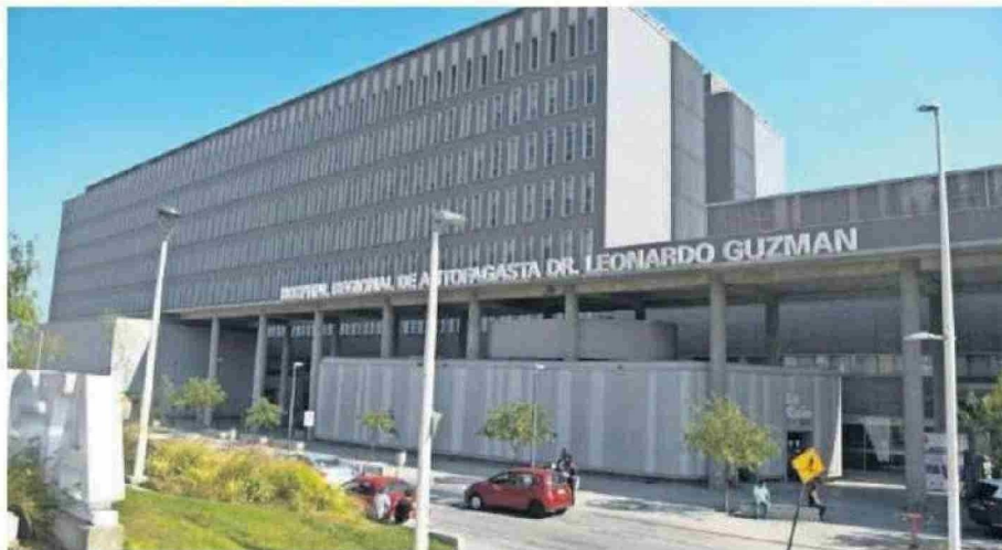
Se suspendieron más de 30 cirugías que se han tenido que suspender por la falla del sistema de climatización.
