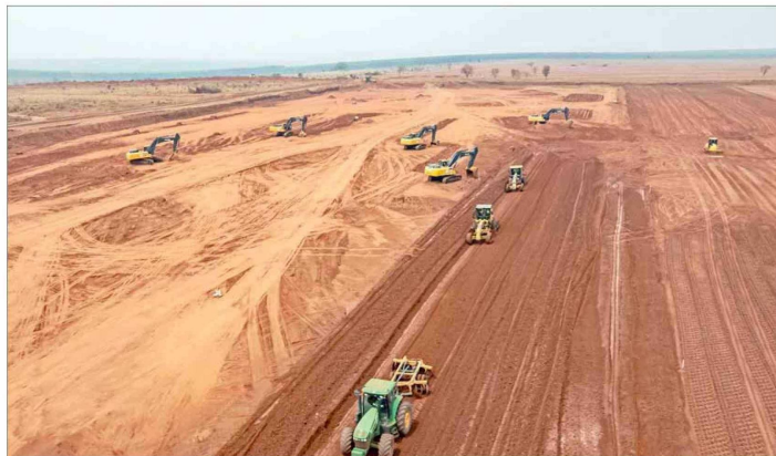
La firma chilena comenzó los movimientos de tierra en Brasil para la construcción del Proyecto Sucuriú, que tendrá una planta con capacidad de producción anual de 3,5 millones de toneladas de celulosa.
