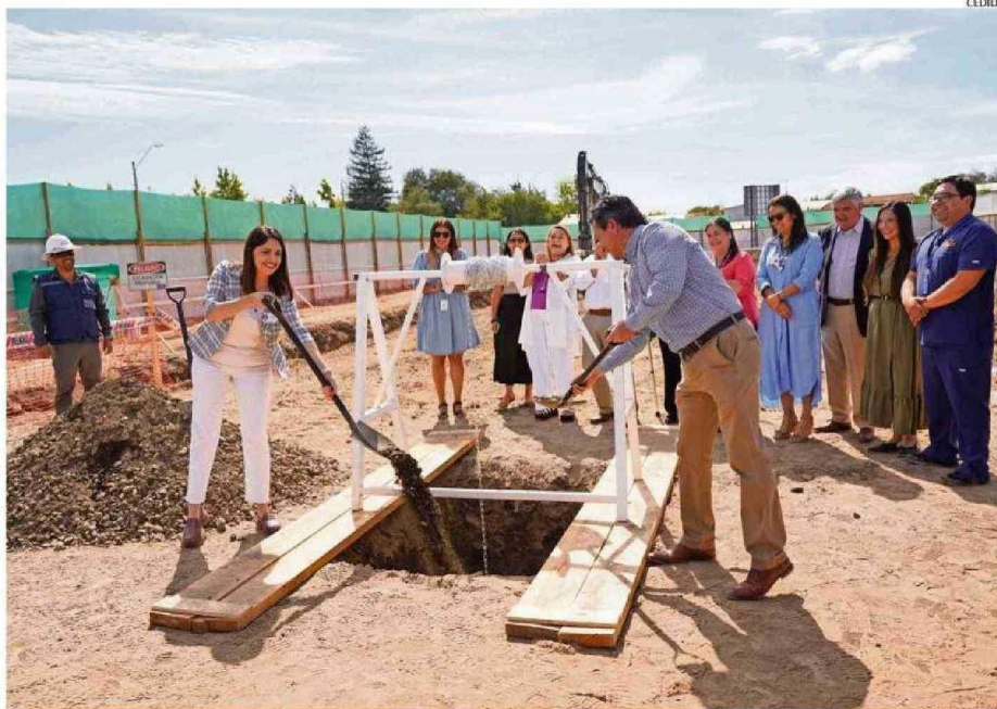
UNO DE LOS HITOS IMPORTANTES, ES EL INICIO DE LAS OBRAS DE REPOSICIÓN DEL CESFAM Y SAR DR JOSÉ DURÁN DE SAN CARLOS.
