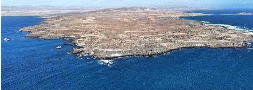
Proyecto Copiaport-E en la costa, cerca de Caldera.
