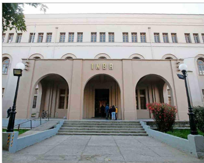
SUCESO. — La explosión ocurrió por la manipulación de elementos incendiarios en uno de los baños del primer piso del inmueble fundado en 1902.
