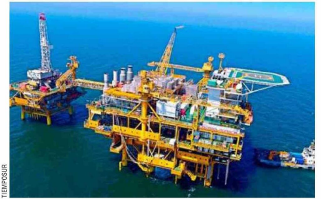
El proyecto desarrollado en tres etapas incluyó la instalación de 36 kilómetros de gasoducto submarino.
