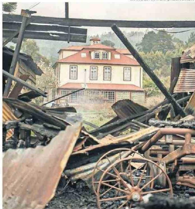
EL MOLINO QUEDÓ COMPLETAMENTE DESTRUIDO.
