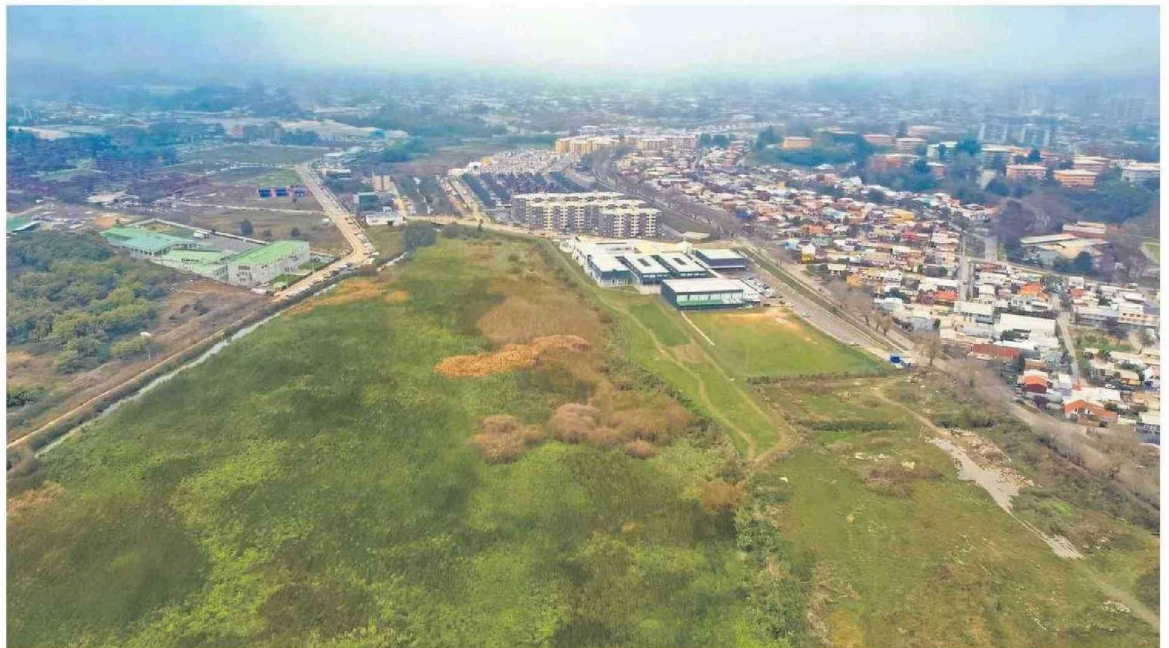
Serviu adquirió el terreno de aproximadamente 10 hectáreas por un monto de 36 mil Unidades de Fomento (UF).
