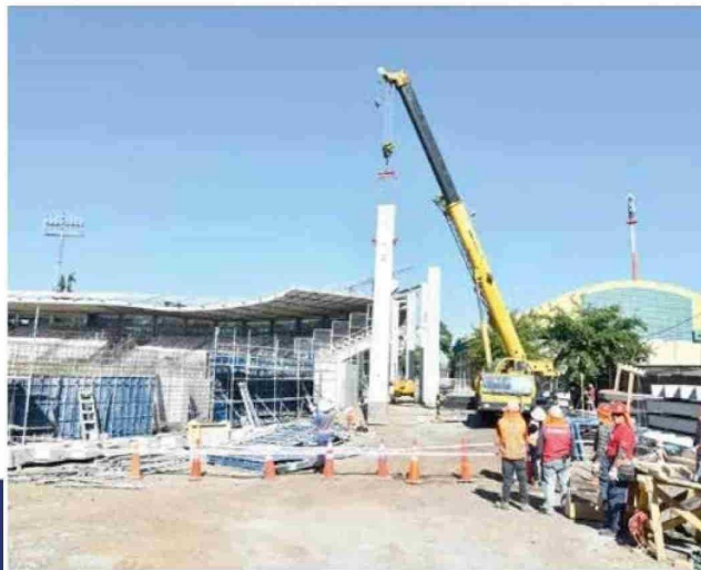
CURICÓ. A raíz de la construcción de la etapa final del estadio La Granja, se dio a conocer que dicho recinto no recibirá eventos masivos durante el año en curso. Diversas autoridades visitaron las obras, que a la fecha presentan un 20% de avance.
