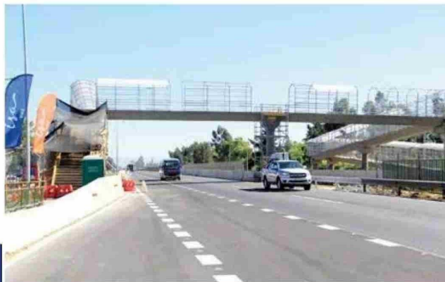
CURICÓ. A fin de mes estaría operativa la nueva pasarela peatonal en el sector Vista Hermosa, un anhelo planteado desde hace años por vecinos. Dicha estructura permitirá poder cruzar con seguridad la Ruta 5 Sur, a la altura del kilómetro 179.
