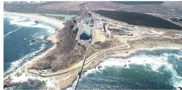
Desde su inicio, el proyecto ha inyectado casi US$2 mil millones en la economía de la región.
