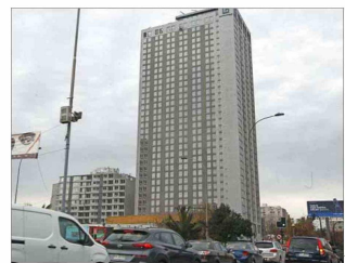
Torre construida en una intersección de alto tránsito en Estación Central.
