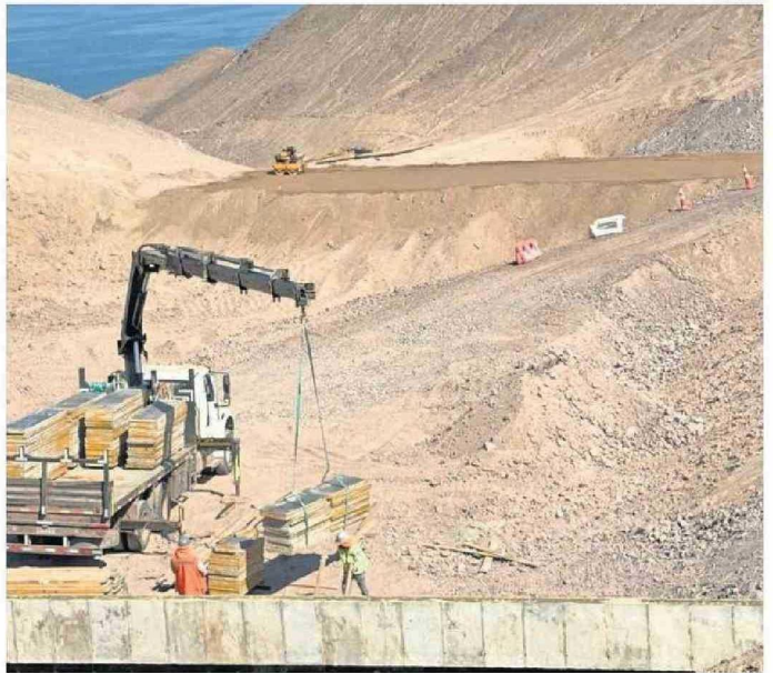
SE REALIZÓ LA CEREMONIA DE COLOCACIÓN DE LA PRIMERA PIEDRA DE LAS OBRAS.
