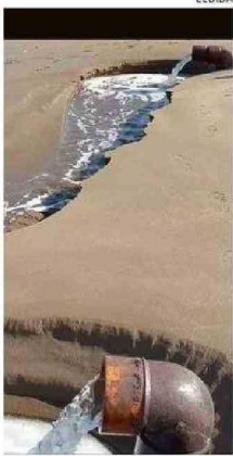
DESCARGA DE AGUA DE MAR.
