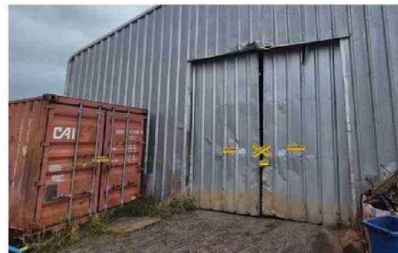
GALPÓN SE OCUPABA COMO BODEGA Y ESTACIONAMIENTO.
