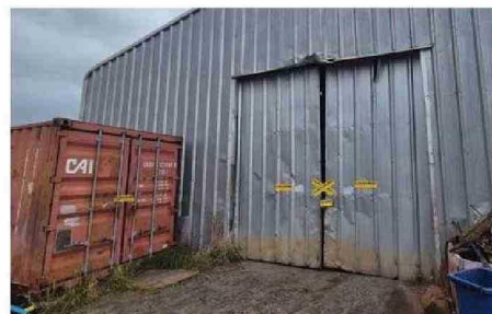
GALPÓN SE OCUPABA COMO BODEGA Y ESTACIONAMIENTO.
