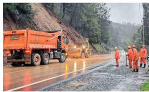
Trabajo en conjunto con la Dirección de Vialidad para habilitar la ruta CH-156 de La Madera.
