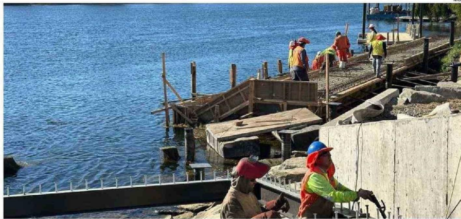
A TODA MÁQUINA AVANZA LA OBRA DE CONSTRUCCIÓN DEL CENDYR NÁUTICO EN LA COMUNA DE CARAHUE, AL BORDE DEL RÍO IMPERIAL.
