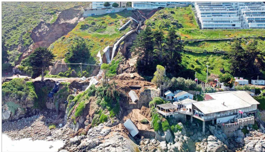
EN ZONA DE RIESGO. — Los edificios desocupados por seguridad quedaron justo enfrente, cerro arriba, del restaurante, causando inquietud en sus ocupantes.
