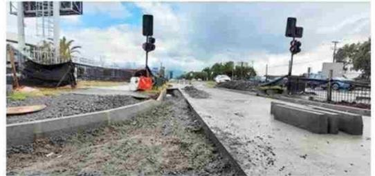
bajos se concentrarán en los puntos críticos del proyecto, como remoción de pavimentos de hormigón, excavación en terreno para obras de drenaje (atravesos y sumideros), pavimento de hormigón para rampas en cruce Bombero Villalobos y San Joaquín de Los Mayos y trabajos de aceras en la vía, entre otras obras.
