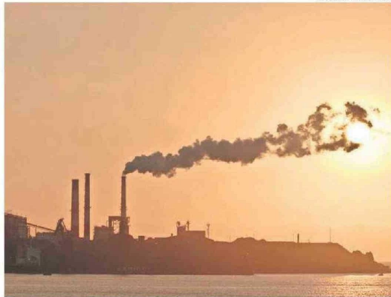
LAS TERMOELÉCTRICAS DE HUASCO HAN RECIBIDO DIVERSOS CUESTIONAMIENTOS DURANTE SU OPERACIÓN.
