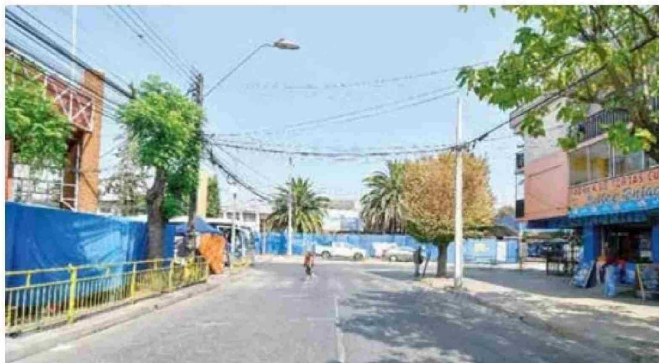
CURICÓ. El comercio curicano lamentó el retraso que tendrá la construcción de la Estación de Trenes de la ciudad, luego de que EFE informara que terminó el vínculo con la empresa contratista, debido a que no cumplió con los plazos de avances de los trabajos.
