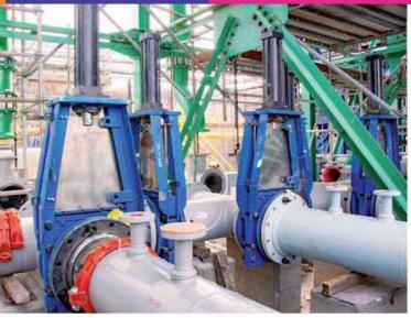
cansa en tres modelos que cubren gran parte del espectro asociado al manejo de fluidos abrasivos en minería: 150 psi; 285 psi; y 700 psi (desde 2 hasta 48 pulgadas), y que pueden ser personalizados, según los requerimientos de cada faena minera.
