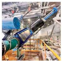
internos que evitan el roce del cuchillo y el cuerpo de la válvula, además de incorporar puntos de lubricación en la misma".
