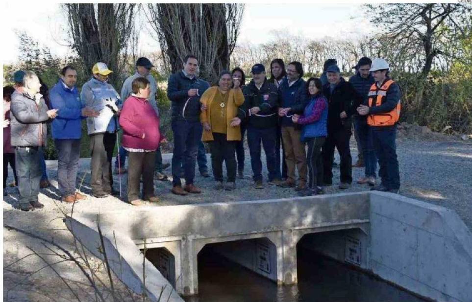
INSTALACIÓN DE CAJONES TRIPLES DE CEMENTO PERMITEN AUMENTO DEL PASO DEL AGUA DEL CANAL EL FARO, EN BULNES.
